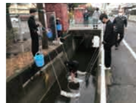
オリジナル浄化装置の設置
